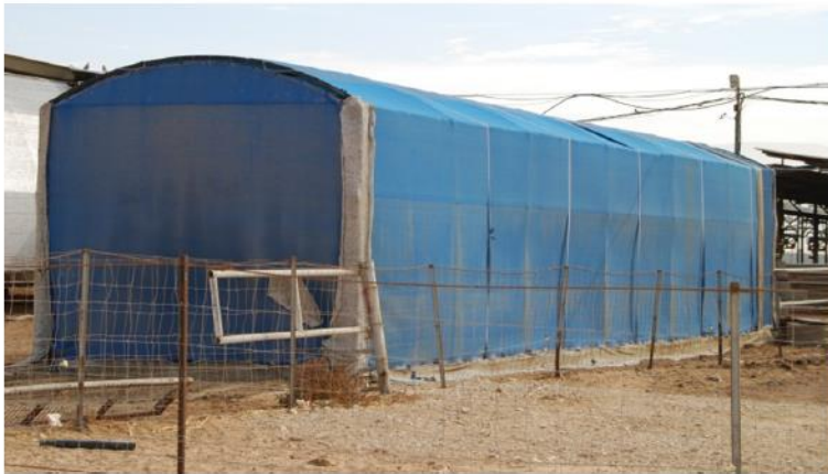
תמונה 2. כיסוי הבור להפרדת מוצקים סטטי ברשת המונעת חדירת זבובים ברפת יהל
